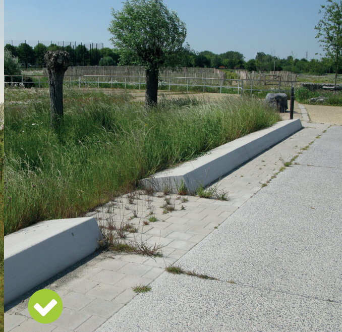
Via speciale openingen in de verhoogde borduren kan regenwater vanaf de straat rechtstreeks afvloeien in de wadi. ©VVOG
