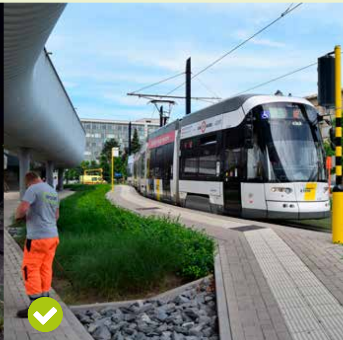
De tramlijn werd doorgetrokken tot midden de campus, bestaande parkeerplaatsen wer- den opgeofferd ten gunste van meer groen.
